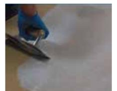
Bei allen Klebesystemen, die für die Verlegung des Bodenbelags verwendet werden, empfiehlt Gerflor immer die Verwendung einer Korkpresse (E6640001) oder eines Korkbesens (E6640002), um einen guten Anfangskontakt und das Entweichen der Luft unter dem Produkt sicherzustellen. Nach beendeter Verlegung sollte die gesamte Bodenfläche in der Länge und Breite des Fahrzeugs mit einer 50 kg schweren Andrückwalze (E6320001) gewalzt werden.
